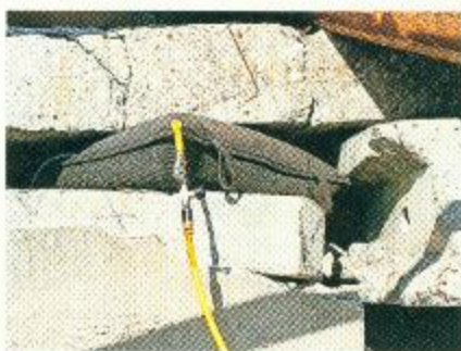
Mit Hebekissen lassen sich schwere Betonelemente spielend leicht anheben.
